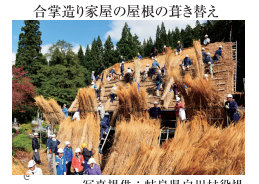
合掌造り家屋の屋根の葺き替え 写真提供：岐阜県白川村役場 白川郷の現在をライブ映像で見ることができます。 白川郷ライブカメラ http://shirakawa-go.org/livecam/
